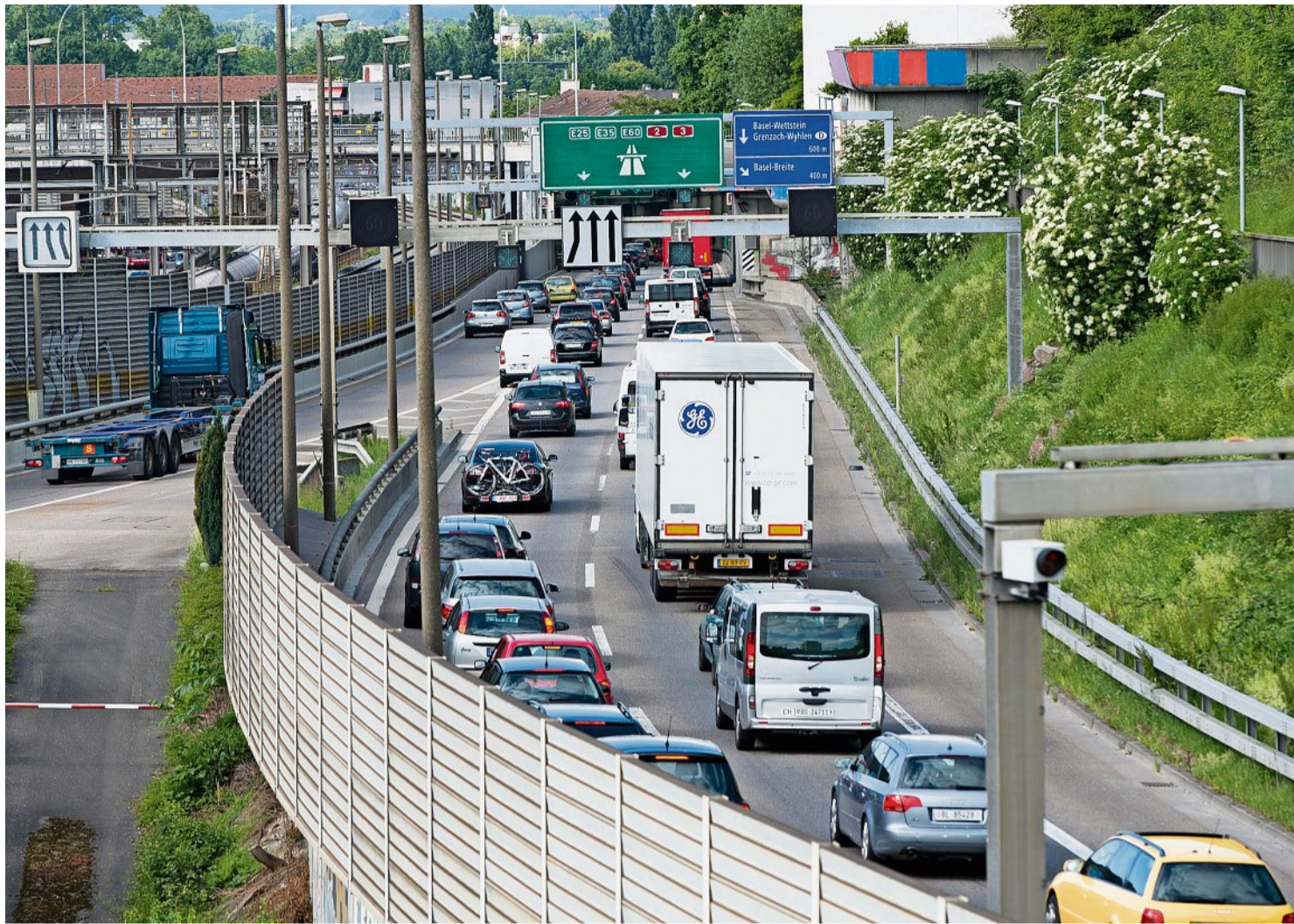
Die Basler Osttangente ist an ihre Kapazitätsgrenze gelangt. Ein Tunnel unter dem Rhein soll Abhilfe schaffen. Foto: Lucia Hunziker
